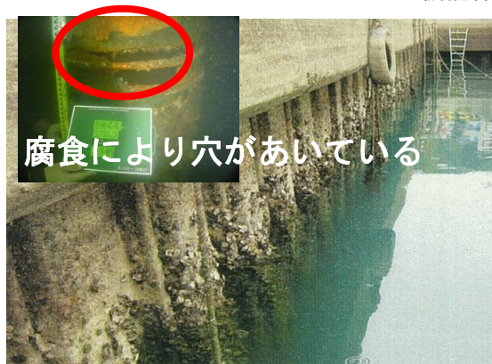
機能保全工事の実施 【着工前】
