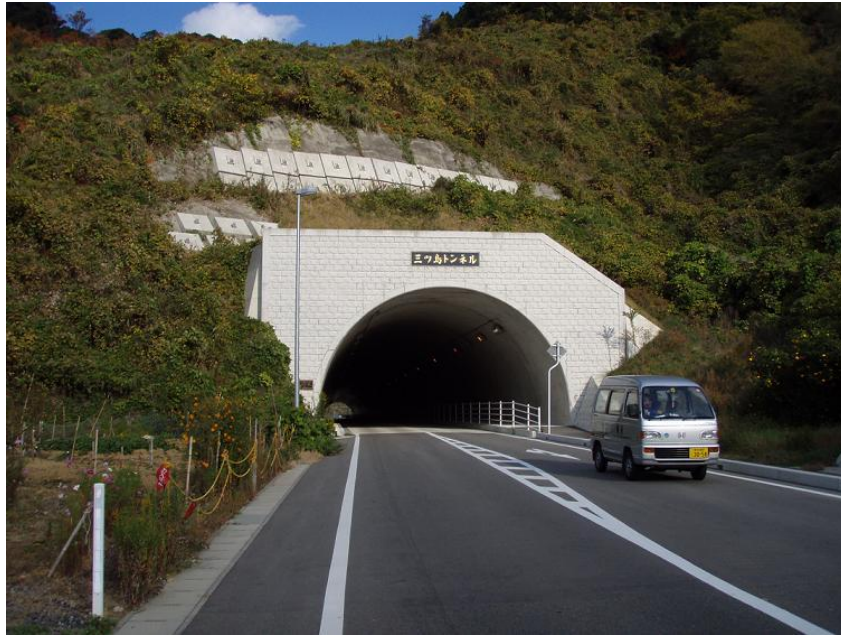
主要地方道 水俣田浦線 緊急地方道路整備事業 (女島工区 ミツ島トンネル)
