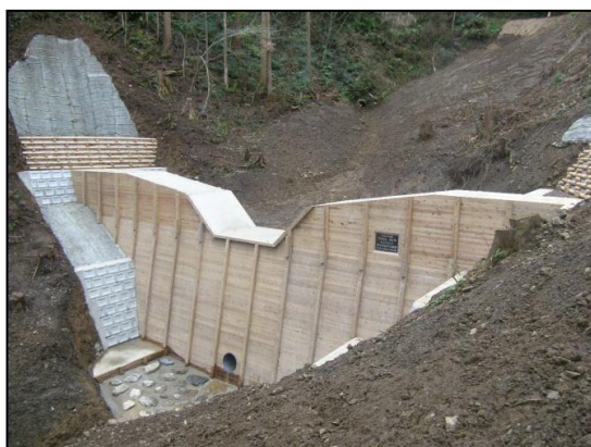
溪間工(谷止工)
