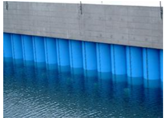
機能保全工事の実施 【竣工】
