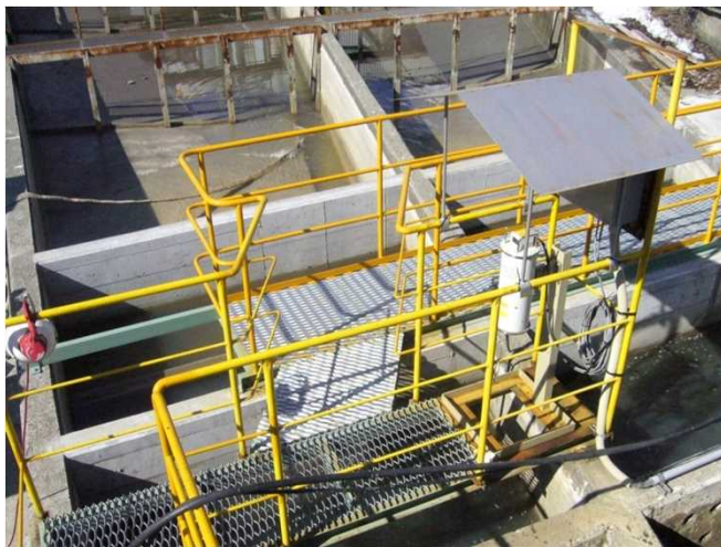
第2沈殿池油膜検知器
