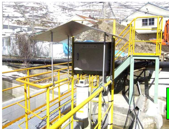
第2沈殿池油膜検知器
