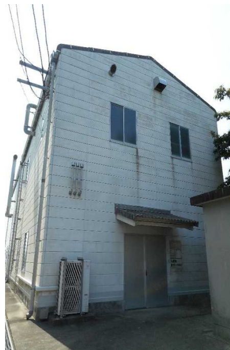
特殊廃液処理施設全体像
