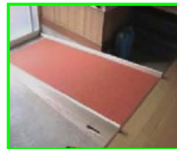
玄関スロープ
