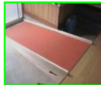
玄関スロープ
