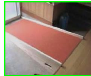
玄関スロープ
