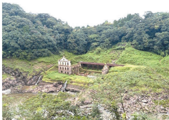
図 2 曾木発電所遺構
